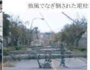
強風でなぎ倒された電柱
