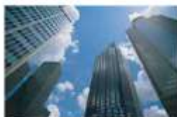
排熱により熱される都市
